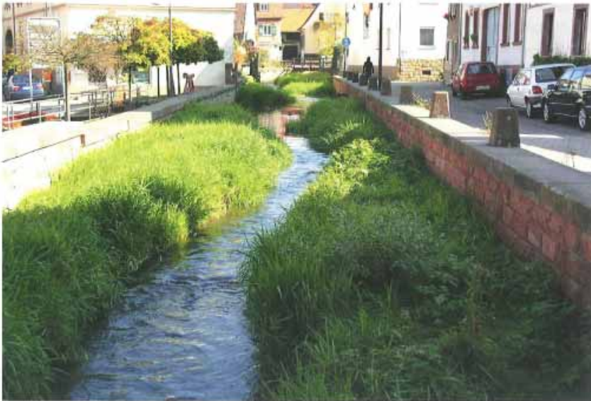
Pendelnder Stromstrich mit unterschiedlichen Strömungsbildern in befestigtem Kastenprofil.
