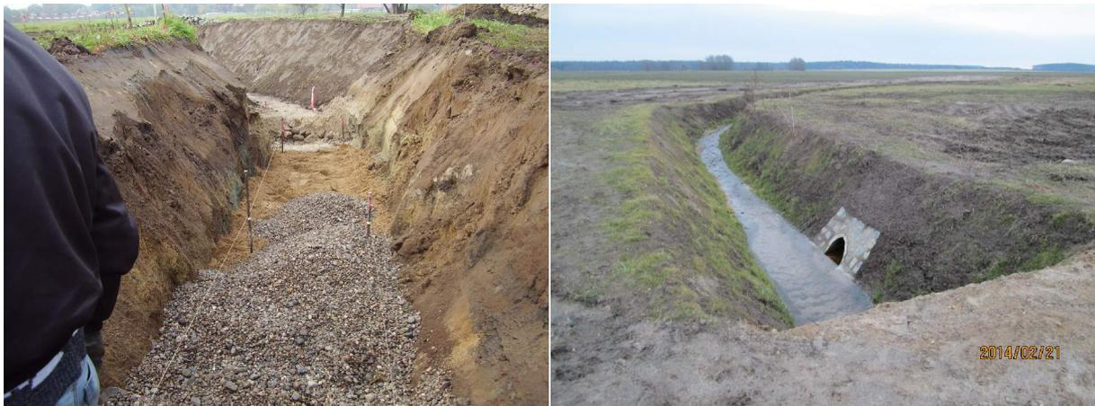
**Abbildung 6 und 7: Sohlgleite im Bau (links) und nach Fertigstellung mit Auslaufbauwerk Brennergraben**
