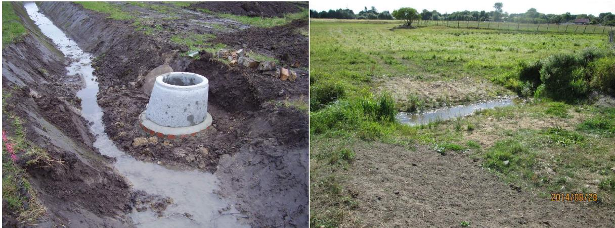
**Abbildung 16 und 17: Schacht im neuen Grabenprofil während der Bauarbeiten (links) und einfache Rinderfurt unterhalb des Bauabschnittes**
