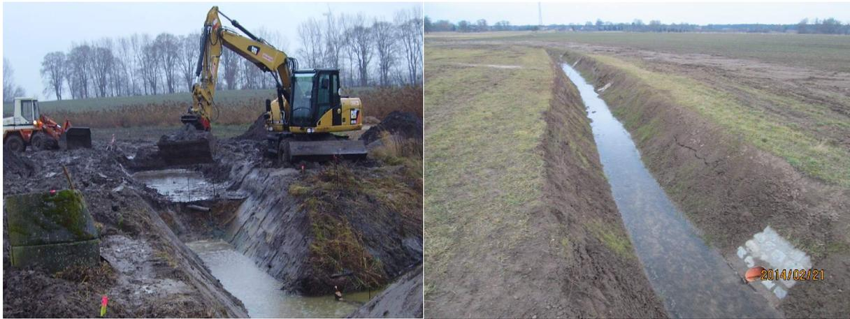
**Abbildung 8 und 9: Bei den Arbeiten angetroffene Drainage (links) und nach Abschluss der Arbeiten**
