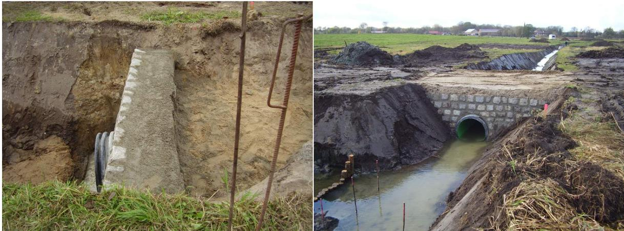
**Abbildung 4 und 5: Landwirtschaftliche Überfahrt im Bau (links) und kurz nach deren Fertigstellung**
