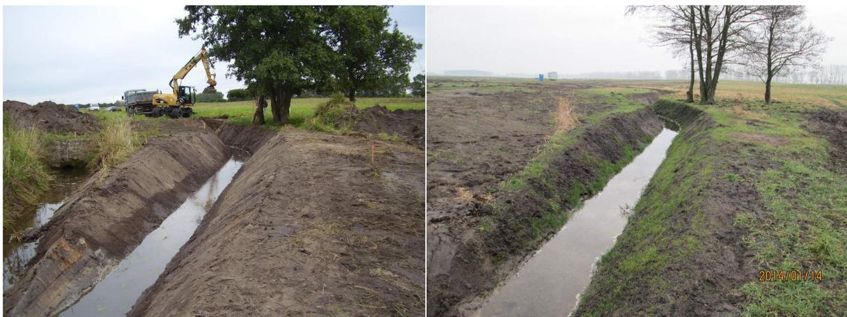
**Abbildung 2 und 3: Alter Auslauf verrohrter Brennergraben (links) und neuer Grabenabschnitt in diesem Bereich**
