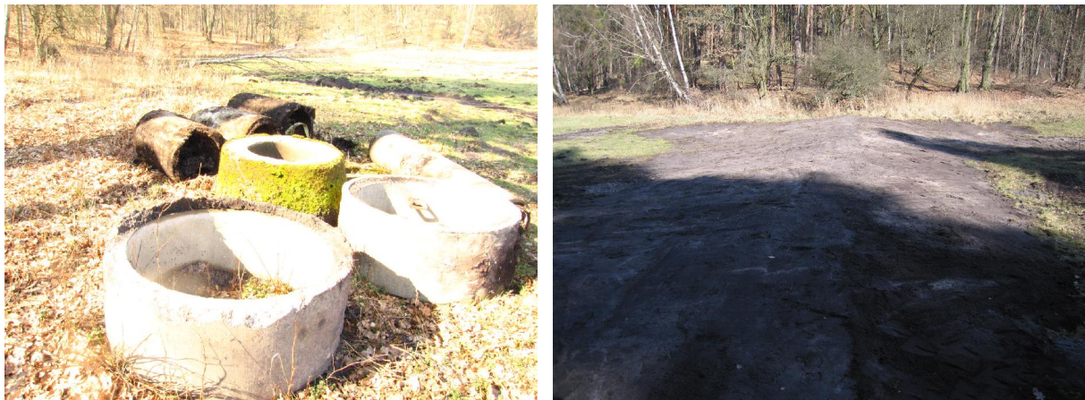
Abb. 5 u. 6: abgerissener Schacht und neu errichteter Torfdamm im Moor D.
