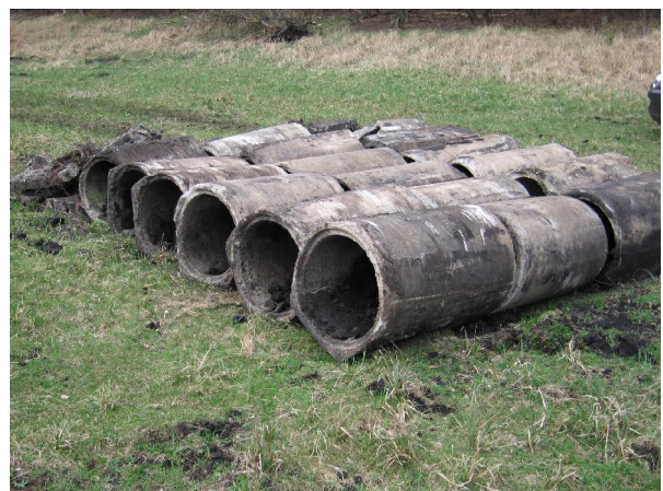
Abb. 9 u. 10: Verfüllter Grabenabschnitt und entfernte Durchlässe aus Graben A.
