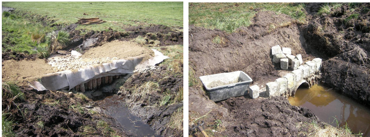
Abb. 11 u. 12: Bauphase Stützwelle im Graben A sowie Instandsetzung Einlaufbauwerk.
