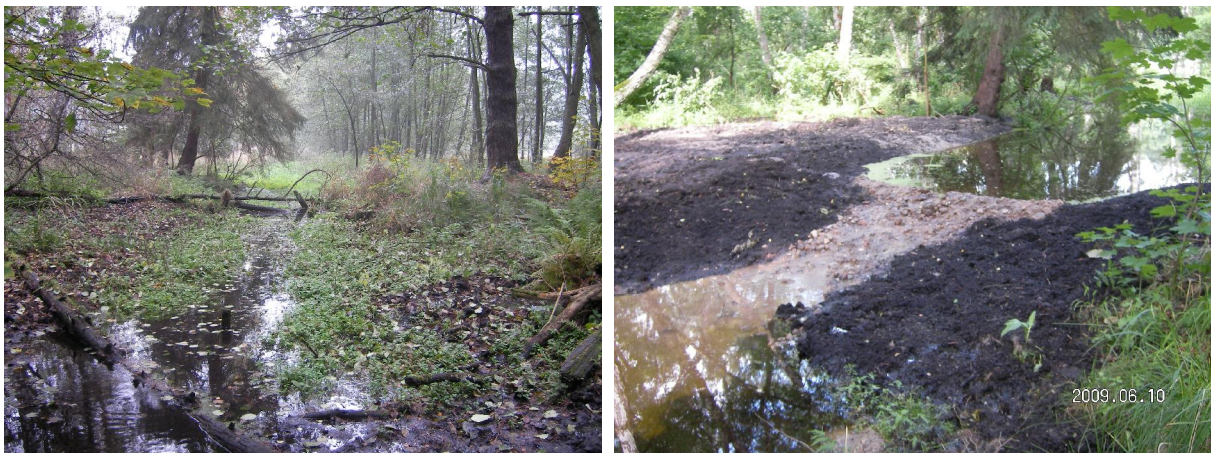
Abb. 23 u. 24: Graben D zwischen östlichem Fliegner Teich und Moor D im Waldbereich vor und nach Errichtung der Stützschwelle.
