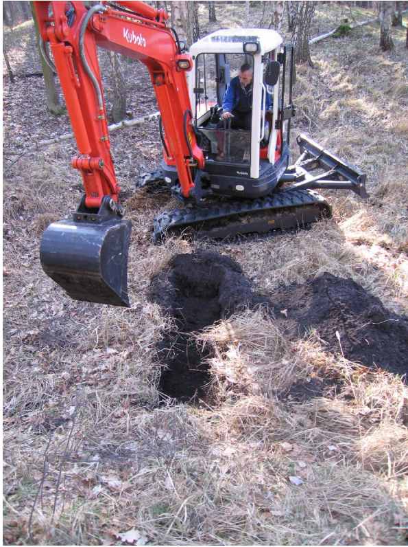
Abb. 7 u. 8: Drainagezerstörung und Ausbau Asbestzementrohr im Moor C.
