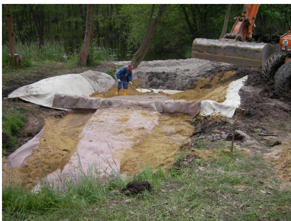
Abb. 19 u. 20: Stützschwelle am Ablaufteich während der Bauphase sowie nach Fertigstellung
