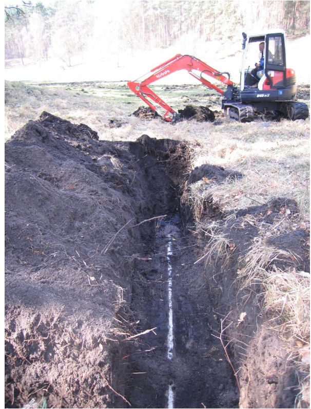
Abb. 7 u. 8: Drainagezerstörung und Ausbau Asbestzementrohr im Moor C.
