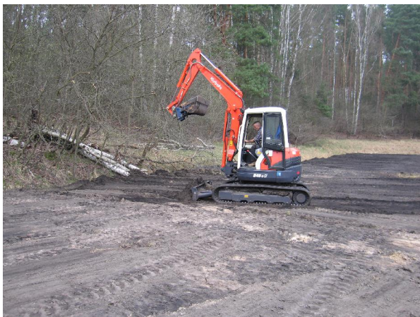
Abb. 9 u. 10: Verfüllter Grabenabschnitt und entfernte Durchlässe aus Graben A.
