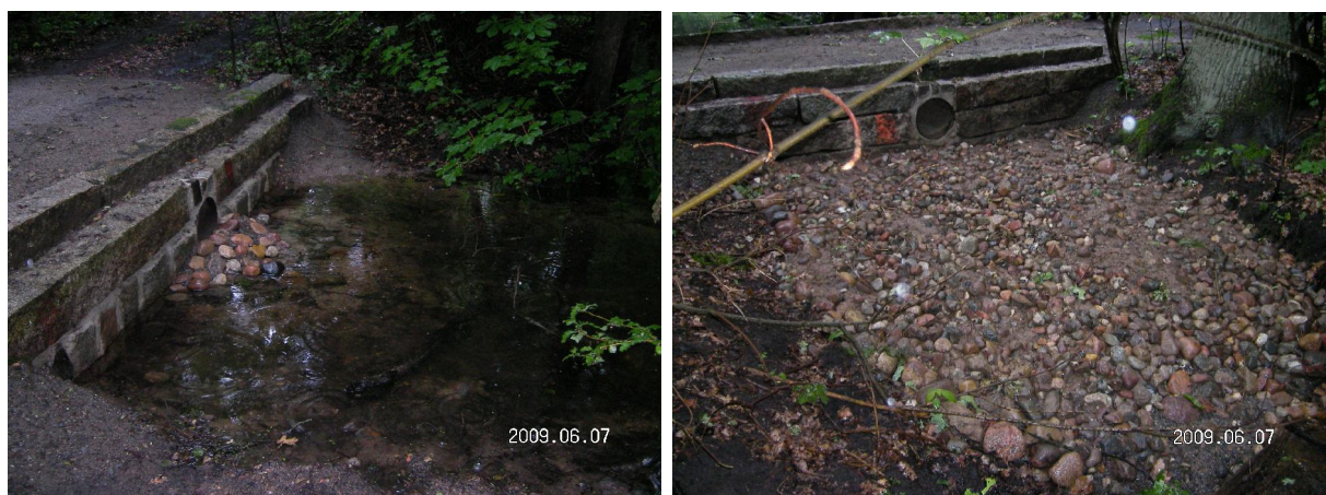
Abb.13 u. 14: Höher gelegter Durchlass im Graben B im Waldbereich: links Einlass; rechts Auslass.
