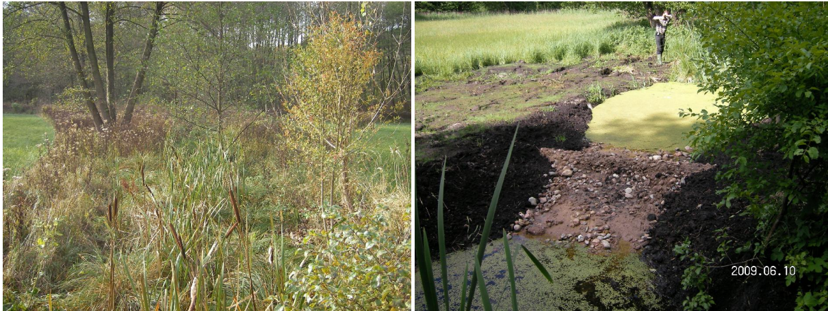
Abb. 21 u. 22: Graben A zwischen den Teichen vor und nach Errichtung der Stützschwelle.
