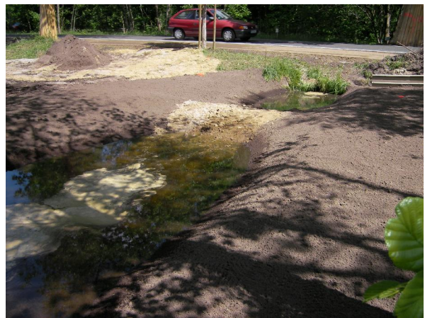
Abb. 19 u. 20: Stützschwelle am Ablaufteich während der Bauphase sowie nach Fertigstellung
