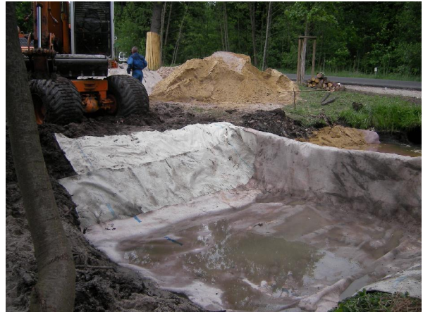
Abb. 17 u. 18: Stützschwelle am Ablaufteich während der Bauphase
