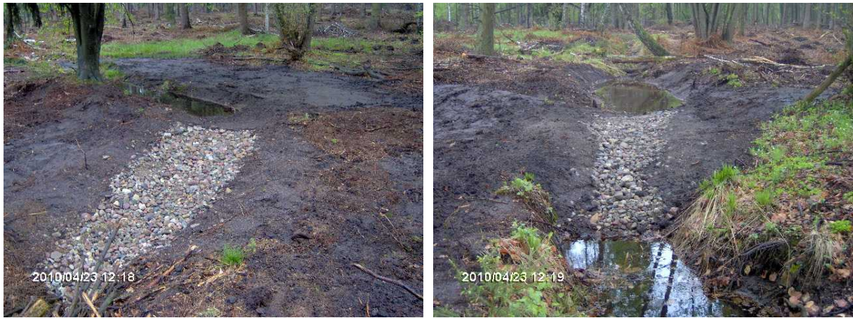
Abb. 10 und 11: Stützschwelen im Ablaufgraben unterhalb der Hagelbergischen Posse
