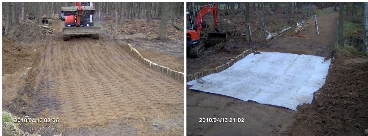
Abb. 6 und 7: Bereich der Furt nach Abriss Durchlasses und Auffüllung mit anlehmigem Füllboden
