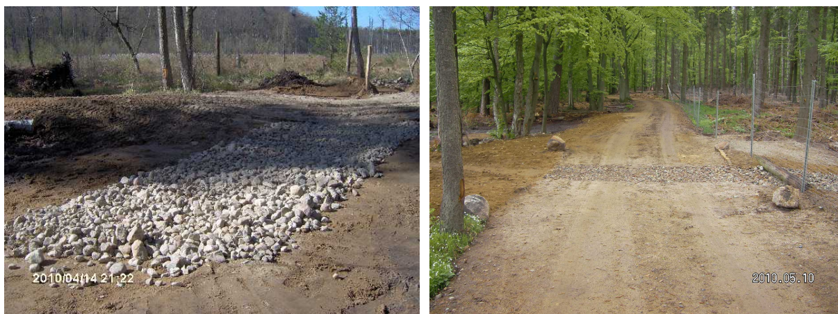
Abb. 8 und 9: Sohlsicherung unterhalb der Furt sowie die Furt nach Abschluss der Arbeiten
