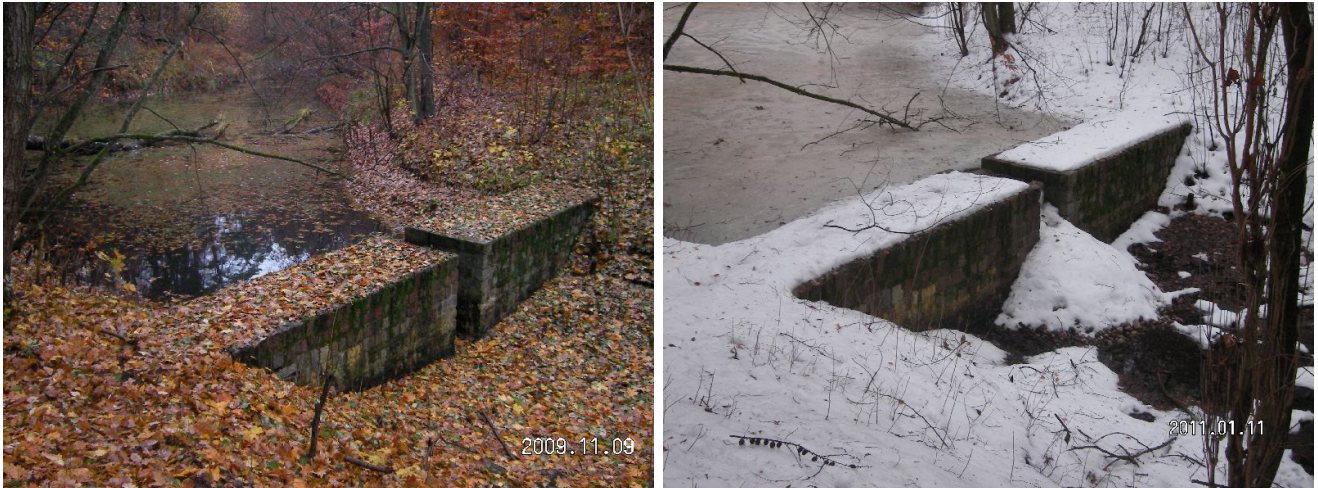
Abbildung 36 und 37: Rückhaltebecken an Station 01+80 vor (links) und nach Umbau
