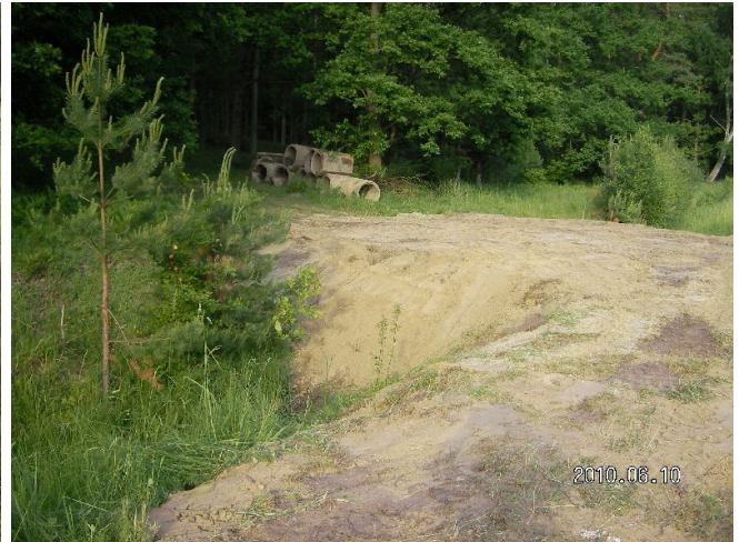
Abbildung 32 und 33: Binnengraben 1 nördlich der Rothschen Wiese als Randgraben mit tiefer Entwässerung (links) und nach punktueller Verfüllung und Rückbau eines Durchlasses.
