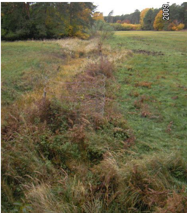
Abbildung 8 und 9: Michengraben im Bereich Michenwiese vor (links) und nach der punktuellen Verfüllung (im Hintergrund ein Standort eines ausgebauten Durchlasses ).
