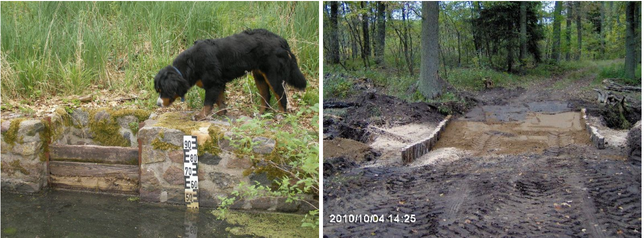
Abbildung 28 und 29: Alter Durchlass mit Staukopf an Station 1,3+70 (links) und während der Bauarbeiten (nach Setzen der Pfahlreihen).
