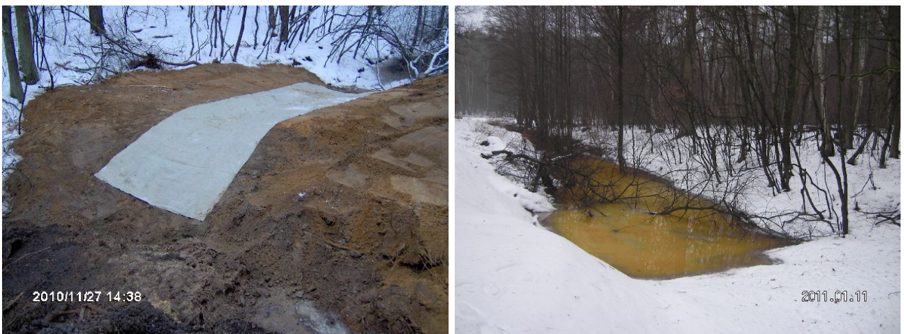
Abbildung 13 und 14: Stützschwelle an Station 1,7+50 im Bau (links) und nach Fertigstellung mit Stauwirkung.
