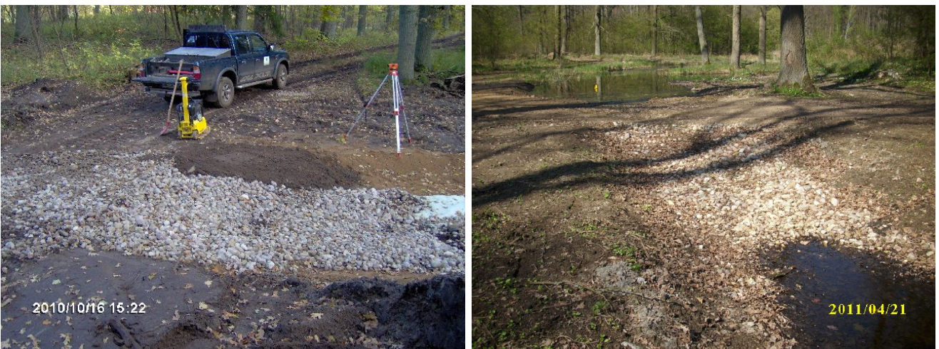
Abbildung 30 und 31: Neue errichtete Furt während der Bauarbeiten (Abdecken mit Siebsteinen; links) und nach Fertigstellung.
