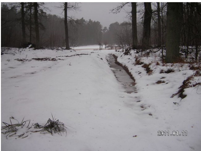
Abbildung 26 und 27: Abschnitt des wieder geöffneten Michengraben nach Abschluss der Bauarbeiten (links) und die Wiedervernässung oberhalb durch die erfolgte Sohlanhebung.
