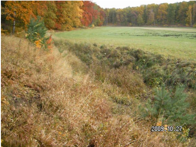
Abbildung 32 und 33: Binnengraben 1 nördlich der Rothschen Wiese als Randgraben mit tiefer Entwässerung (links) und nach punktueller Verfüllung und Rückbau eines Durchlasses.
