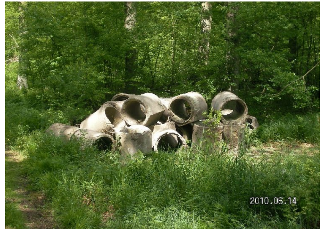
Abbildung 24 und 25: Abschnitt des wieder geöffneten Michengraben während der Bauarbeiten (links) und die ausgebauten Beton-Durchlass-Segmente DN 800.
