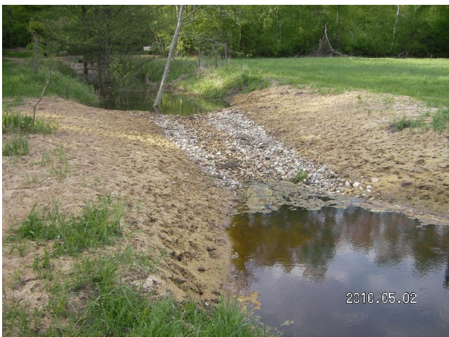
Abbildung 22 und 23: Neu errichtete Stützschwelle an Station 1,6+35 und Vernässung durch Torfdamm an an Station 1,5+75.
