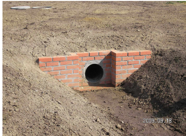
Abb.29 und 30: Schachtfundament und fertiges Einlassbauwerk mit Schachtdeckel im Hintergrund am Ablauf Schulzensee / Bahngraben Chorin
