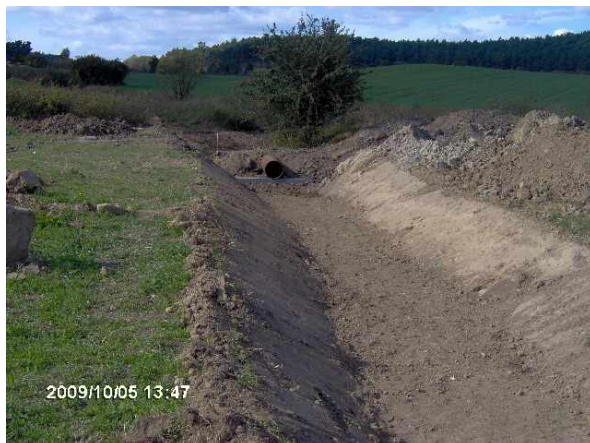
Abb. 10 u. 11: Beginn des Grabenaushubs mit Durchlass am 05. und 08.10.2010
