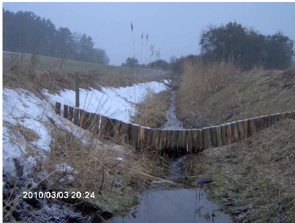
Abb. 16 u. 17: Pfahlreihe für und fertiggestellte Stützwand oberhalb des Feuchtgebietes
