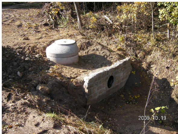
Abb. 7 u. 8: Schacht und Einlaufbauwerk Diebelpfehl während und nach Abschluss der Bauarbeiten
