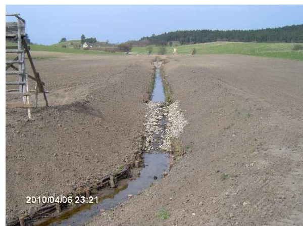
Abb. 14 u. 15: Bodenaushub und fertiggestellter neuer Grabenabschnitt
