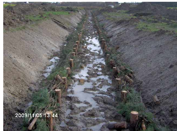
Abb. 12 u. 13: Sohlgleite im Bau und faschinierter Grabenabschnitt
