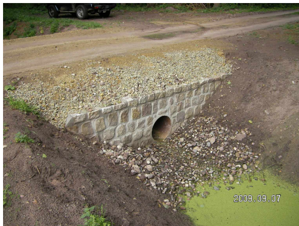
Abb.24 u. 25: Abriss alter Betonrohrleitung und Ersatz durch einen Durchlass aus Stahl DN 500
