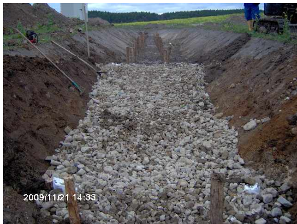
Abb. 12 u. 13: Sohlgleite im Bau und faschinierter Grabenabschnitt
