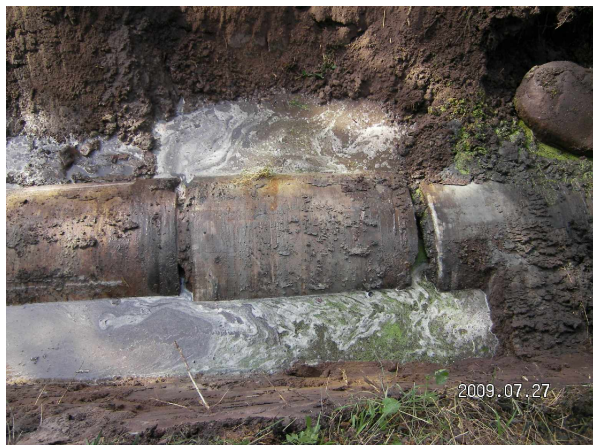
Abb.24 u. 25: Abriss alter Betonrohrleitung und Ersatz durch einen Durchlass aus Stahl DN 500
