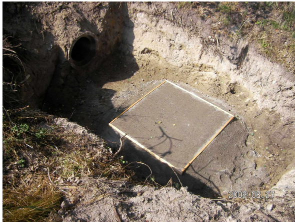
Abb. 5 u. 6: Schachtfundament und Schacht für Einbau Ablauf Reusenpfehl
