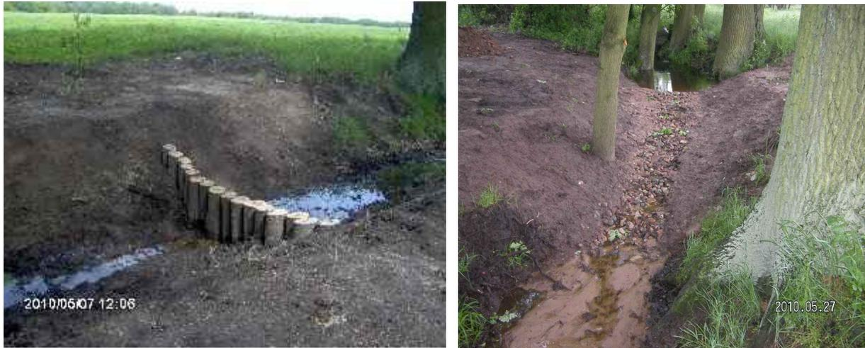
**Abb. 5 u. 6: Mittlere Stützwälle Ablaufgraben Fasanenwäldchen im Bau (links) und unterste Schwelle nach Fertigstellung**
