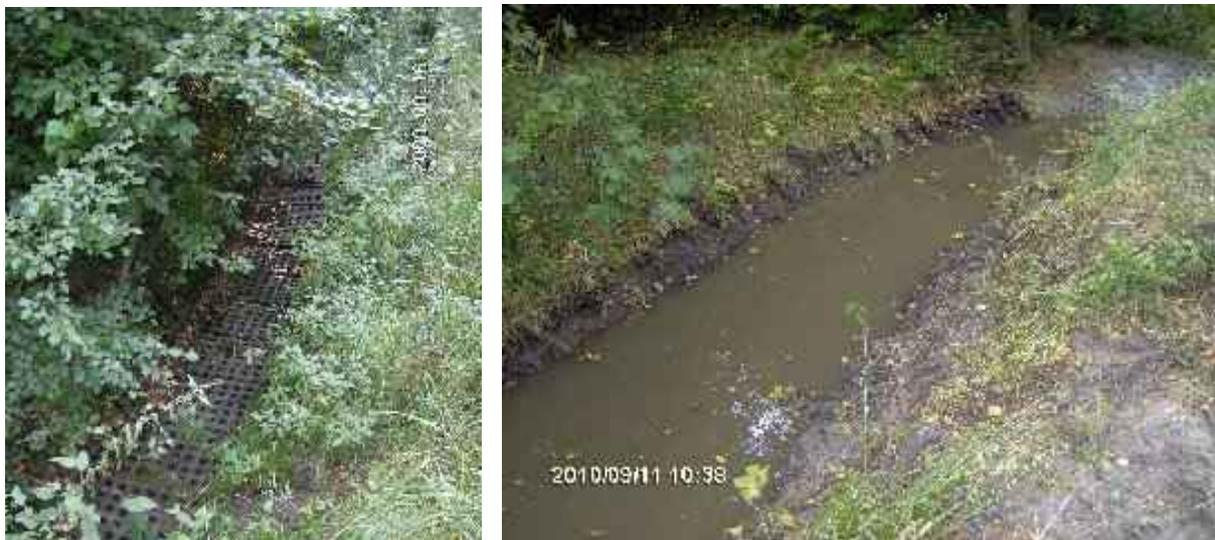
**Abb. 26 u. 27: Rasengitterplatten vor Projektbeginn (links) und entsiegelter Abschnitt nach Umsetzung des Projektes (rechts)**
