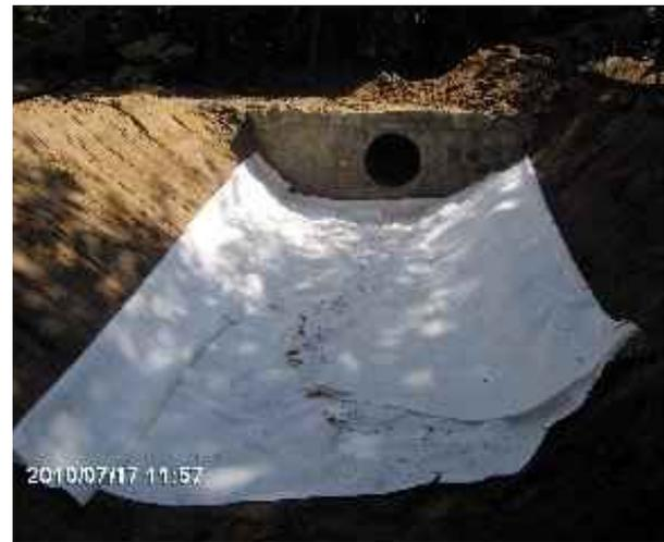
**Abb. 17 u. 18: Neubau Durchlass unterhalb Strömungslenker (Bau Stirnwände links und Nachbettsicherung rechts)**
