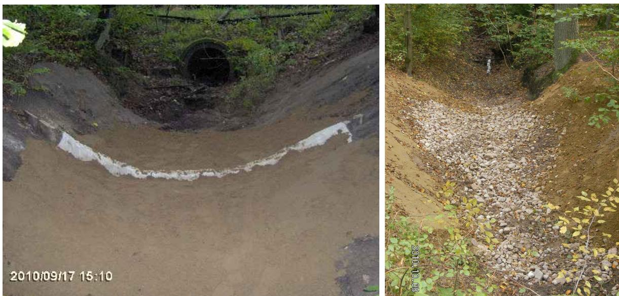
**Abb. 32 u. 33: Stützschwelle Leuenberger Wiesengraben im Bau (links) und nach Fertigstellung (rechts)**
