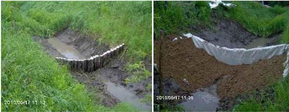
Abb. 2 u. 3: Stützschwelle Krüge: Eichenpfahlreihe links und Tondichtungsbahn rechts
