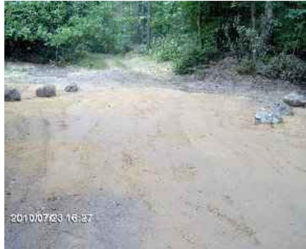
**Abb. 19 u. 20: Nachbettsicherung Durchlass (links) und wiederhergestellte Überfahrt (rechts)**
