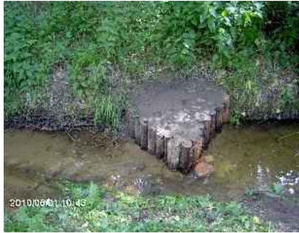
**Abb.15 u. 16: Strömungslenker in in Form von Dreiecksbunnen**
