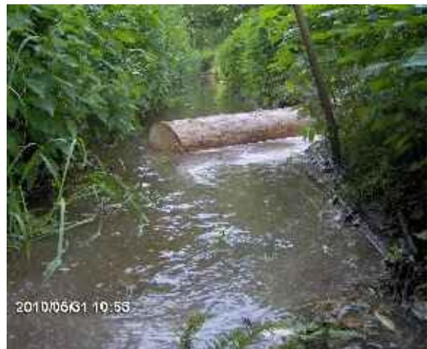
**Abb.11 u. 12: Strömungsenker in Form von Stammhölzern**
