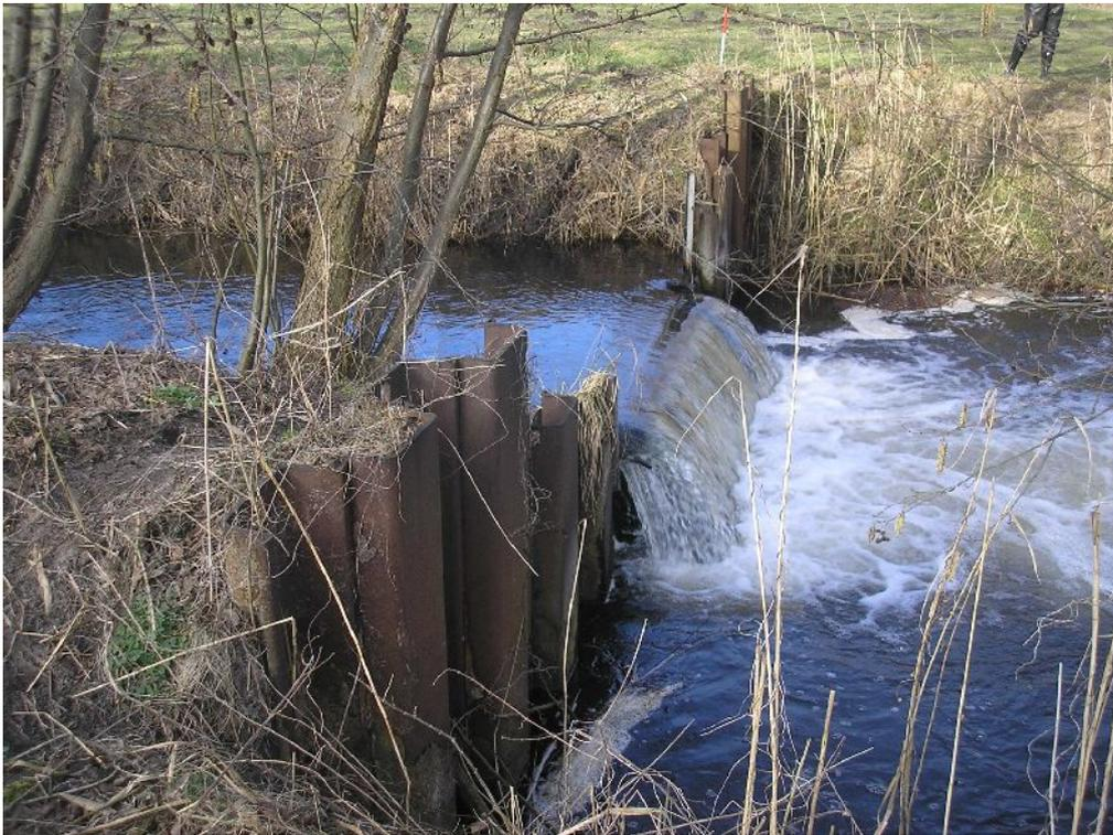
Abb. 3: Altbestand des Spundwandwehres an der Kietzmühle.
