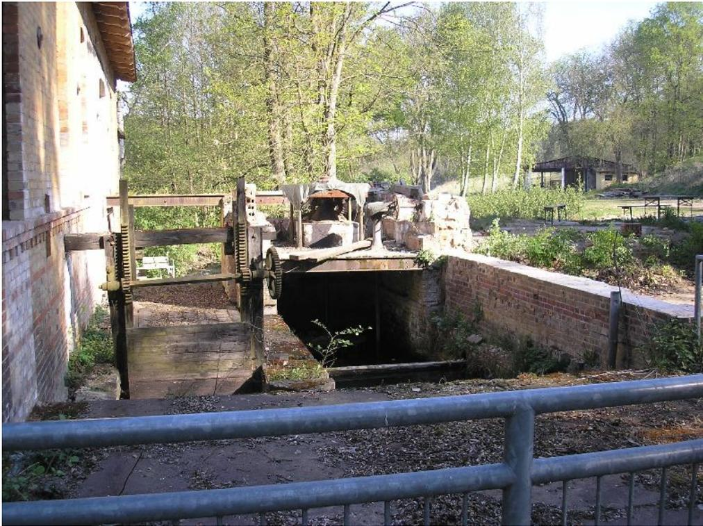
Abb. 1: Altbestand der Wehranlage mit Turbine an der Wehrmühle (Blick vom Oberwasser).
