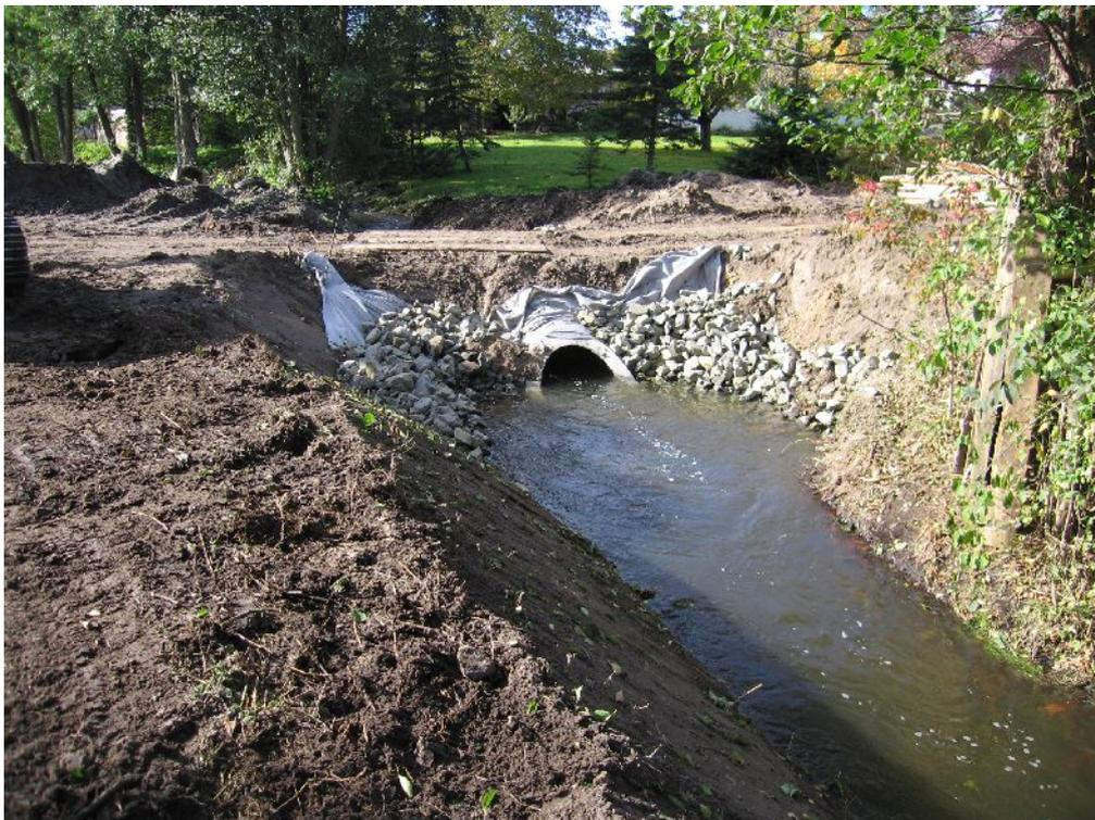
Abb. 4: Neu errichteter Durchlass DN 1000 an der Zufahrt zur Wiesenfläche.
